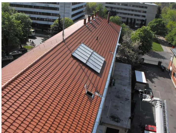
Az új cserépfedés a napkollektorokkal
